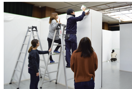
部屋の養生作業
